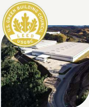
Galpão Logístico LEED GOLD
