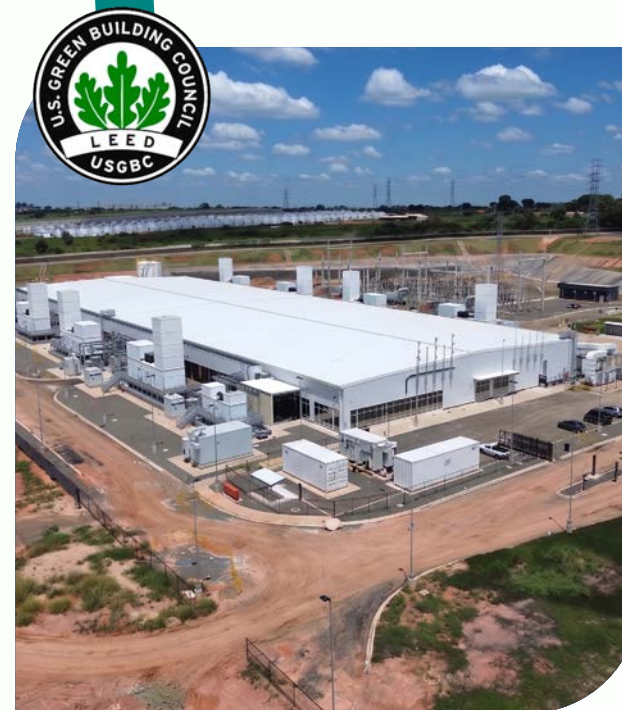
Data Center Hortolândia
