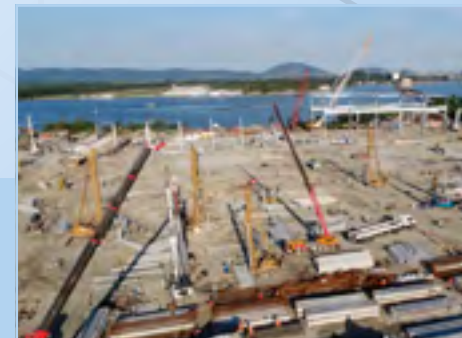
A SETE executou para a Afonso França as fundações do Terminal de armazenamento de celulose na Ilha Barnabé em Santos - SP.
