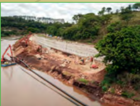
Implantação de Cortina Atirantada em Brumadinho/MG – Execução Progeo Engenharia
